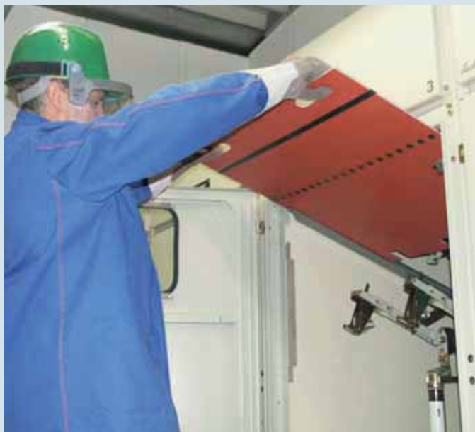
Einbringen einer Schutzplatte der Bauform A1 von Hand.
